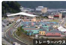
トレーラーハウス
